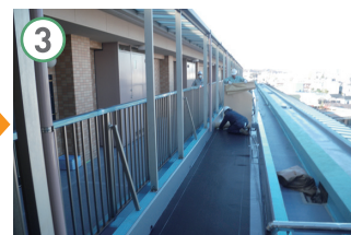
③ ガムロールFX施工
