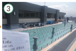
FDコーンH86施工
