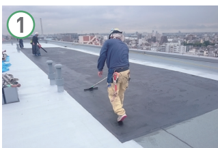
リベース施工
