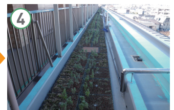
④ GCユニット施工
