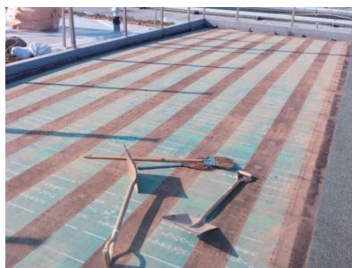
植栽ユニット撤去
