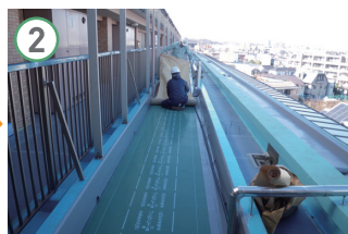
② エコムガード施工
