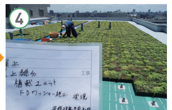
ユニット設置
