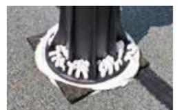
樹脂製束設置部の防水層と保護材
