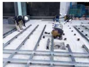
根太を大引上に設置し、ビス固定します。根太の設置間隔は、仕上げ材によって異なります。
