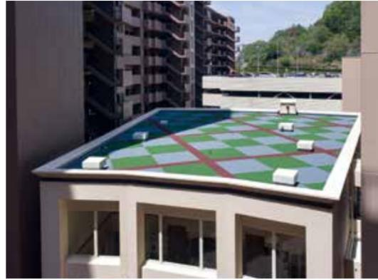
厚さ6mmのアスファルト系砂付成型板。表面に焼付彩色した砂粒(または自然色砂粒)を隙間なく密着させた保護仕上げ材です。2色あるいは3色を組合せて、楽しくカラフルなパターン仕上げも可能です。
