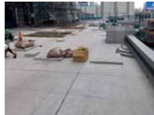
樹脂製束設置位置を墨出します。FDウッド、タイル、パネルの仕上げに関わらず、X軸・Y軸ともに800mm間隔が標準となります。強風地域や重荷重へ対応する場合には、600mm、480mm、400mmなど間隔を狭く設定します。
