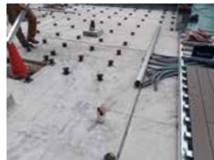
仕上げ高さに合わせてレベル調整をしながら、樹脂製束をスーパーUダイン(一液型ウレタン系接着剤)で固定します。
