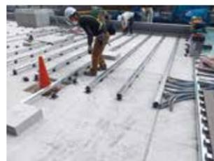
大引を樹脂製束の中心に据え、ビス固定します。耐負圧計算において更に強度を必要とする場合には、ビスの本数を増やして対応します。
