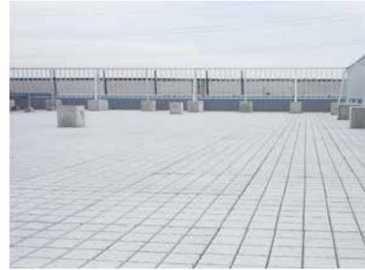
セメントと硬質骨材との混合と合成繊維メッシュで補強された成型板。防水層の上に置き敷きする簡単施工です。目地部分で折り曲げ、下地の不陸等に馴染ませて設置します。
