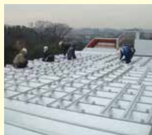
③ SRG下レール仮置き
