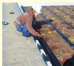
⑦ SRG見切り材固定
