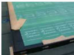
FDウォール取付け
