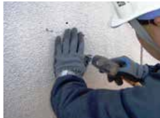
アンカー打込み
