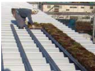
エコムユニットを荷揚げして設置する。
