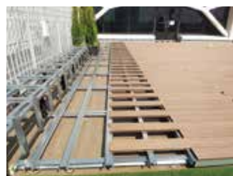
デッキ材の目地寸法を5mm取りながら固定金具で固定する。
