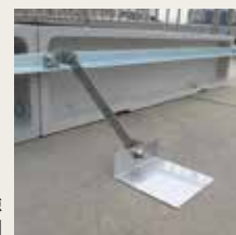
転倒防止用補強 プレート設置例
