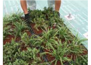
水下側よりGCユニット敷設
