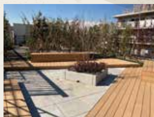
多目的広場 ・ウッドデッキベンチ ・PCパネル
