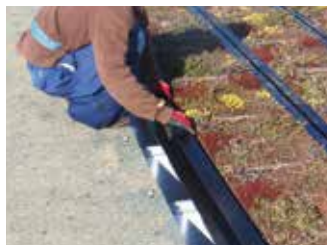
SRG見切金物を、押え金具およびSRG下レールへ固定する。
