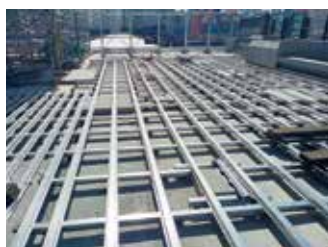
下地組み完成。
