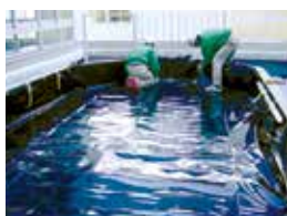
FDフィルム敷設
