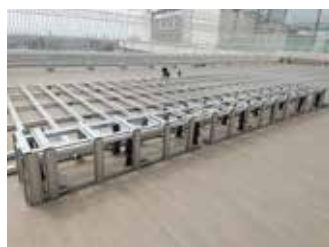
下地組みの高さを変えて、ベンチも施工可能。
