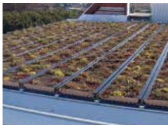
SRG押えレールを下レールの上に重ね、ナットで固定する。
