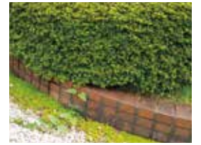
レンガ積み施工例
