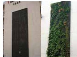
パネル取付け後、植栽する。 右画像：施工約3年後の様子。
