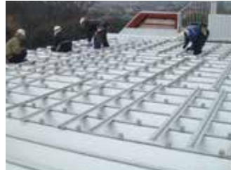
SRG下レール仮置き
