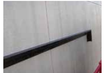
ツルパワーガード本体の取付け
