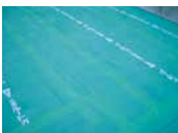
ルートガードD貼付け
