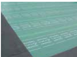
エコムガード貼付け
