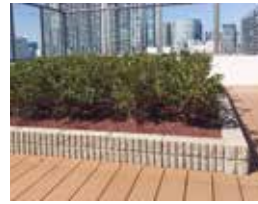
化粧ブロック施工例
