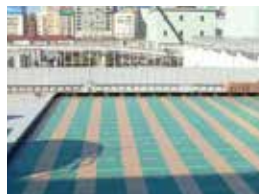
エコムテープ20貼付け
