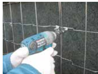
ナット締めをしてパネルを固定する。(1枚のパネルにつき9カ所固定)
