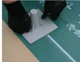
FDコーンH86取付け
